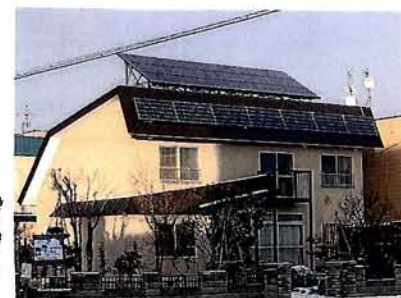
★南向き屋根に22枚の太陽光パネルを設置しました。
