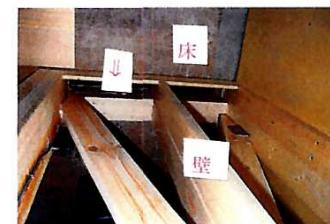
④室内を廻った空気は最終的に2階の天井からパイプを通って建物の外へ誘導します。
