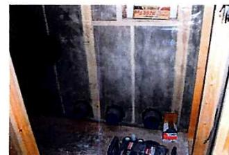
③床下で温めた空気が1階～2階へ移動し、さらに1階に戻って来るための空間です
